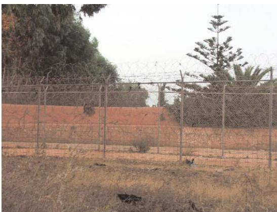
Valla que separa la frontera entre Marruecos y España. En ciertos tramos, la valla alcanza una altura de cinco metros
